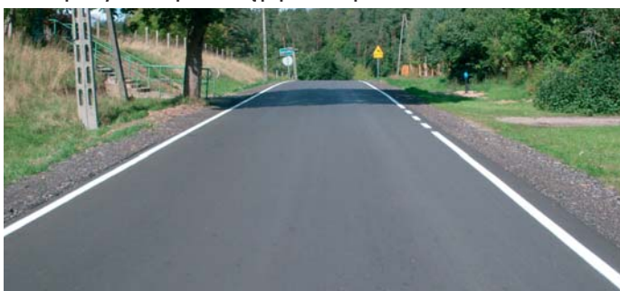
Szeroka, równa jak stół, doskonale oznakowana z nowymi poboczami – taka jest wyremontowana droga na odcinku 2,5 km z Kobuły w kierunku miejscowości Rudziska
